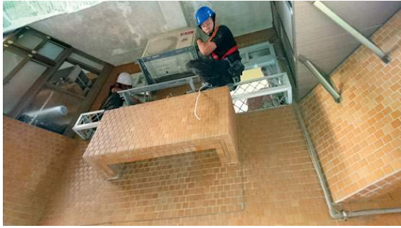
特力屋冷氣安裝工班使用背負式安全帶作業
